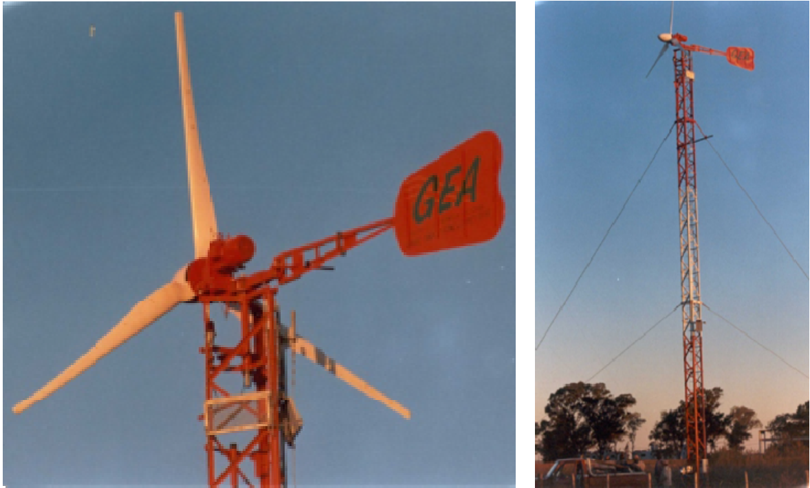
Fig. 5. Generador eólico montado en el predio de la Universidad Nacional de Río Cuarto.
