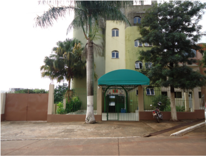
Photo n° 1 – Vue extérieure du Collège
