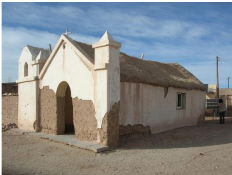
Foto 1 Micro-red fotovoltaica en Pozo Colorado, Provincia de Jujuy.
