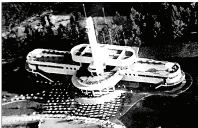
FIGURA 5 | edificio Playas Serranas. Autores: Manuel y Arturo Civit. Fuente: Corominas Segura, R. (1942) Labor de Gobierno , Mendoza: Imprenta Oficial, s/p.
