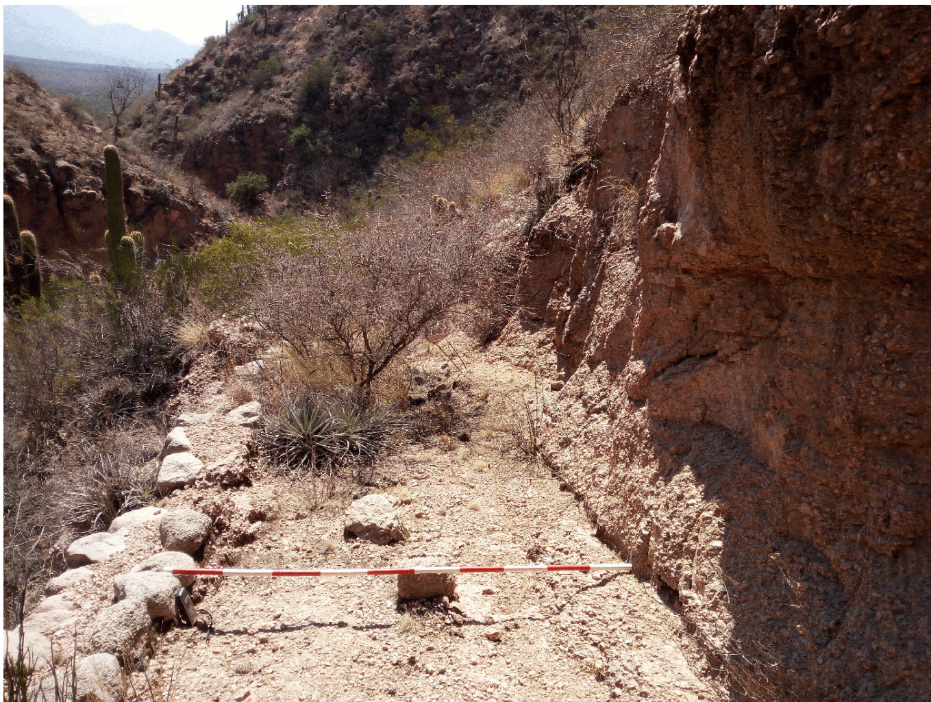
Figura 2. Segmento de camino con talud, excavación ladera adentro y muro de protección.
