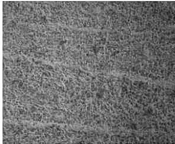
Pavimento de hormigón
