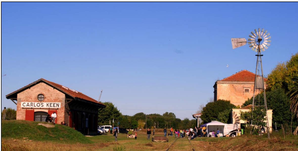
Foto 3: vista del predio ferroviario donde funciona “El Granero”.
