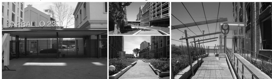
FIGURA 8 | UG2 - sector 1, “Forum”, fotografías construcción (nov. 2013)
