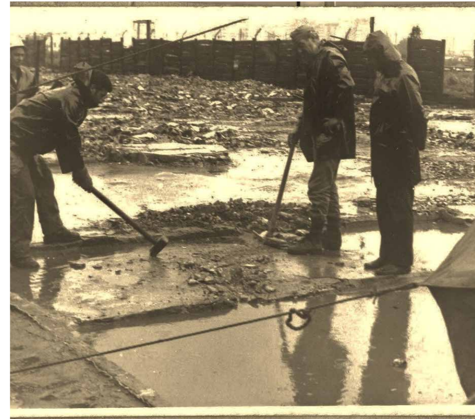
Foto 7. Demolición de viviendas, fase final del Plan de Erradicación de Villas
