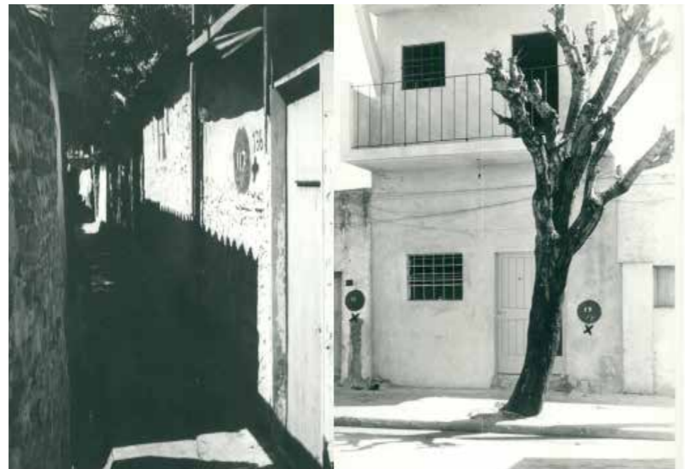
Foto 5. Casillas marcadas durante los operativos de erradicación. Entre las viviendas afectadas se puede apreciar importantes diferencias en términos de la calidad de la construcción, siendo demolidas tanto las casillas consolidadas como las más precarias
