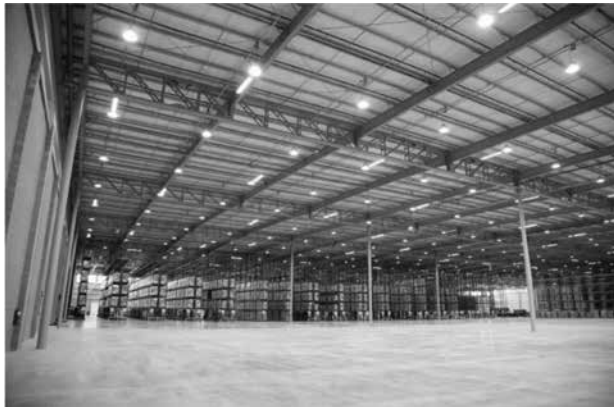
Plaza logística Pilar. 48000 m 2 de galpones para el depósito de aerosoles más grande de Latinoamérica. Piso diseñado en paños de 10 m x 10 m. Reducción de más del 50 % de metros lineales de juntas.
