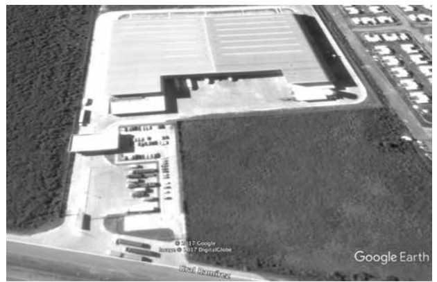
Centro de distribución de Día en Paraná. 20000 m 2 de pavimento en paños de 7,50 m x 6,50 m. Las macrofibras sintéticas facilitan la formulación de HRF empleando rodados triturados de la zona.
