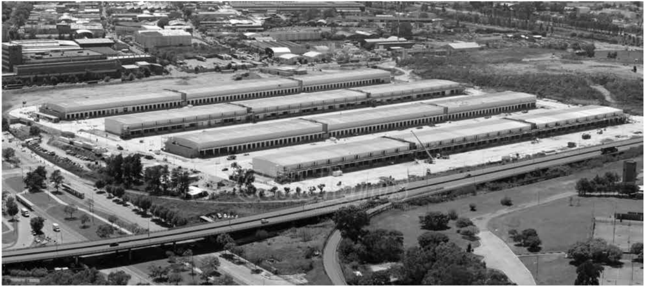
Centro de transferencia de cargas (CTC) – Villa Soldati – CABA. 112 módulos de 990 m 2 cada uno, distribuidos en 4 naves y conectados por 110000 m 2 de pavimento. Fueron construidos sobre el antiguo basural de la Ciudad de Buenos Aires. Ejemplo del uso de los HRF para fundar pavimentos sobre suelos pobres.
