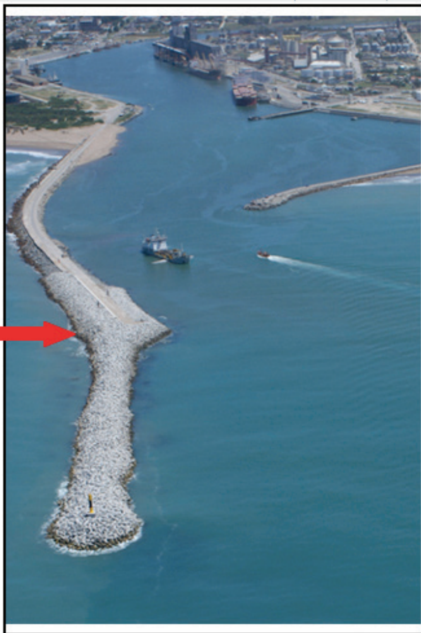
Fig. 1. Vista de la escollera sur con la obra ya finalizada y la ubicación del dispositivo undimotriz
