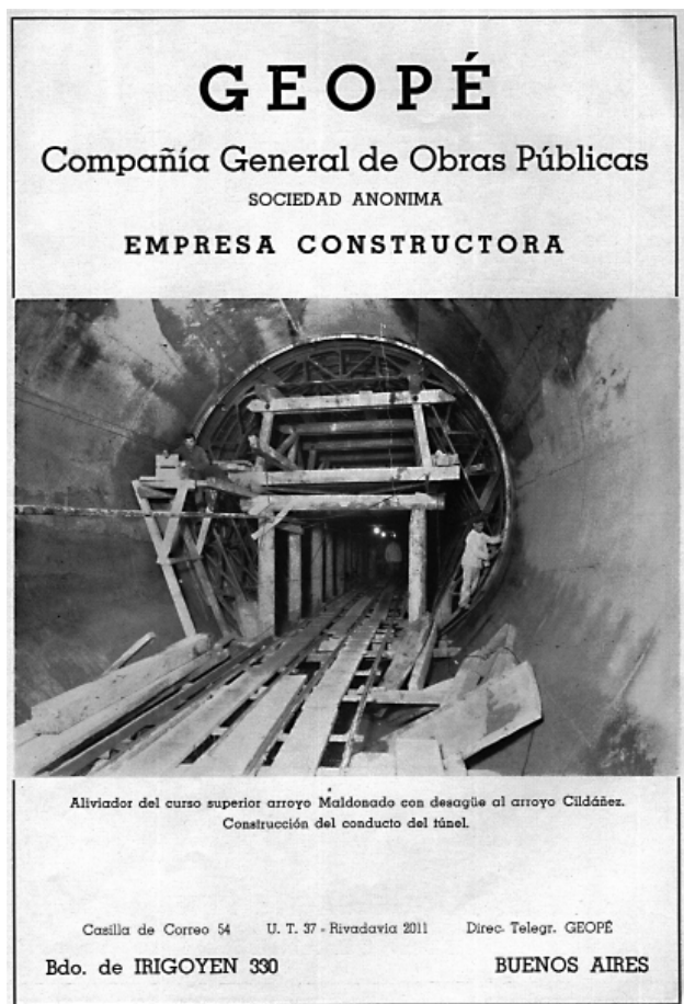
Imagen 6. Construcción del conducto del túnel aliviador del curso superior del arroyo Maldonado con desagüe al arroyo Cildáñez
