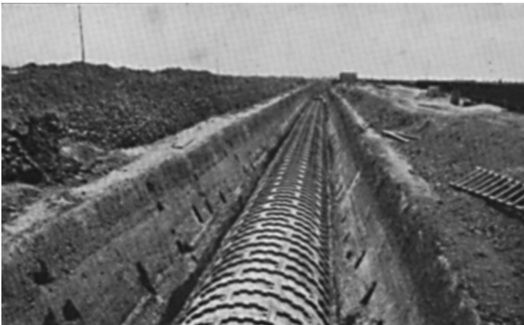
Imagen 7. Conducto de hierro fundido de 3 m de diámetro entre Sarandí y Wilde para la VIª sección de la cloaca máxima
