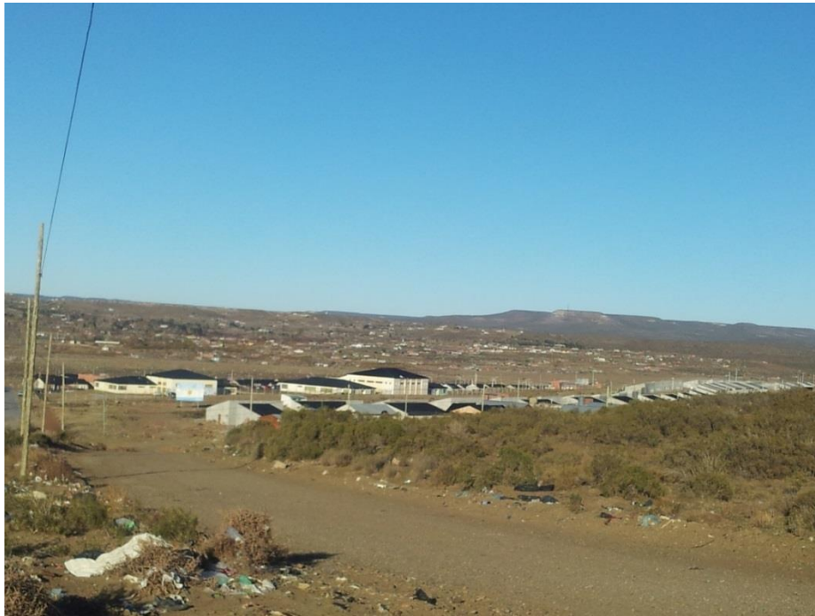
Foto N° 8: Vista en altura del predio educativo. Hacia la derecha, se observa el edificio de la escuela primaria, el gimnasio compartido y el sector donde funciona la ES2. Hacia la izquierda, el jardín de infantes. Se aprecian algunas viviendas de planes estatales y descampados utilizados como depósitos de basura
