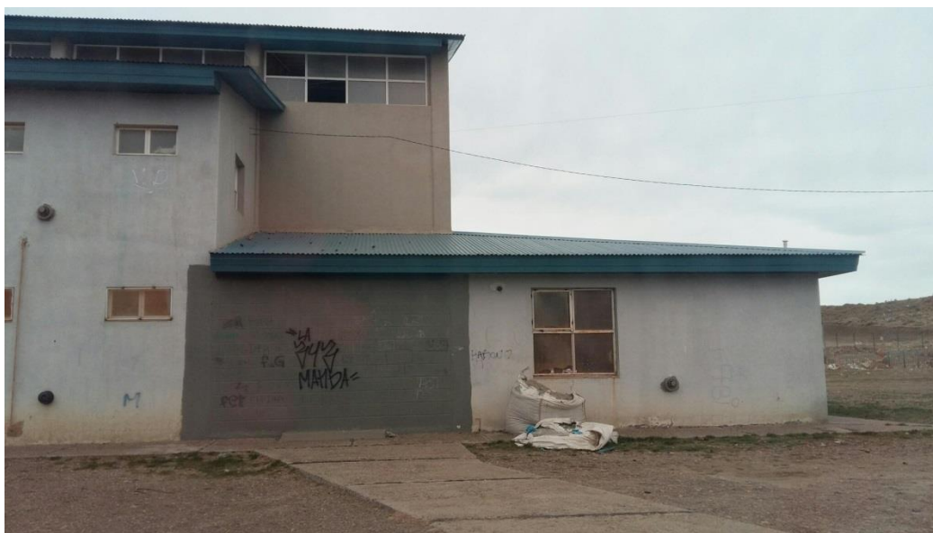
Foto N° 5: Cerramiento externo del hall para habilitación de nueva aula
