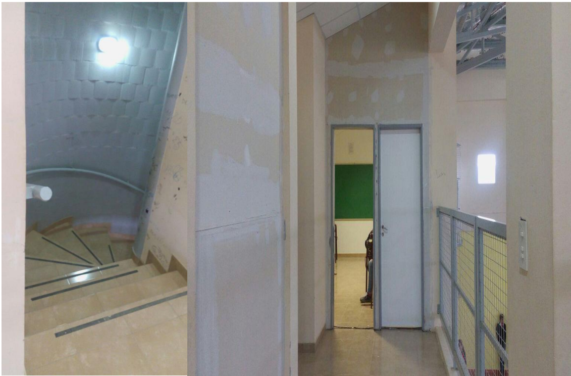
Foto N°12: Hacia la derecha: el pasillo y la entrada al aula en el gimnasio. Hacia la izquierda: escalera caracol de acceso al aula
