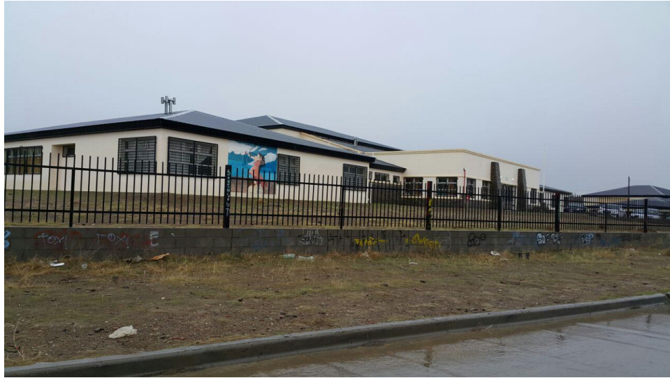
Foto N°7: Vista frontal de la ES1. La escuela funciona en el sector izquierdo del edificio
