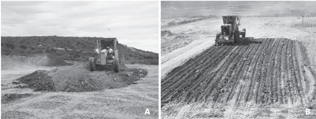
Foto 19. (A) Distribución en campo del sustrato con la proporción 1:1 de DS/SS (M2). (B) Escarificado del terreno
