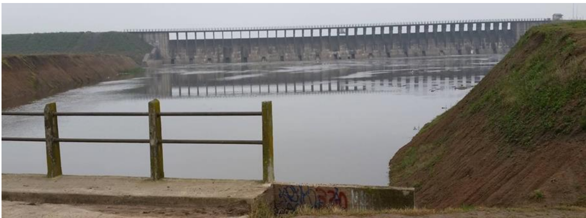
Figura 1.4: Fotografía de la represa Roggero, inicio del cauce principal del río Reconquista.
