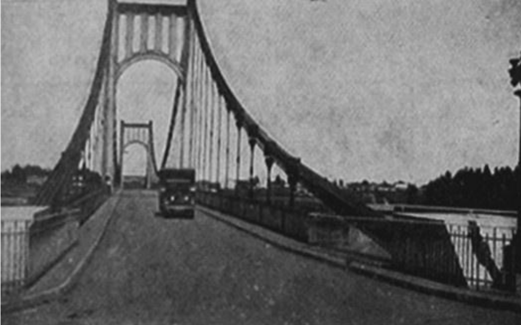
Necochea, puente sobre el río Quequén Imagen divulgación [GTdS, 1937, p. 50]
