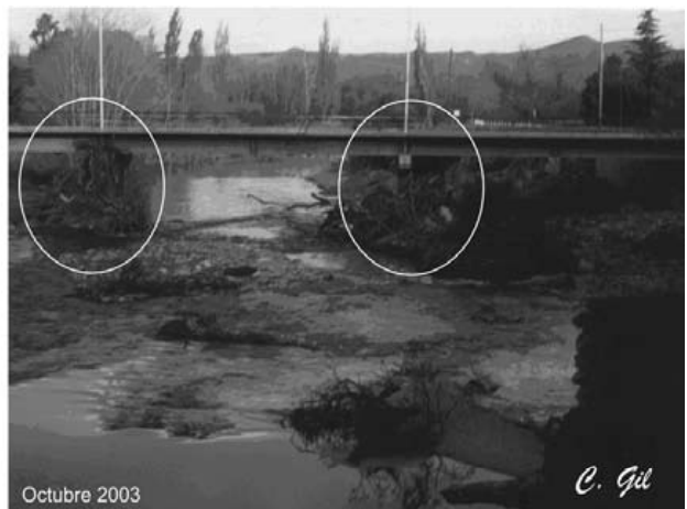
Figura N° 2. Puente entre Villa La Arcadia y Sierra de la Ventana. En la fotografía de octubre se observa la resaca en las pilas que sostienen el puente luego de la crecida del 7 de octubre. El agua sobrepasó el puente 1,5 m.
