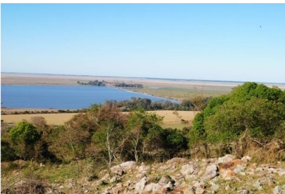
Figura 4. Vista del embalse que detiene el paso del agua de la cañada Guaviraví
