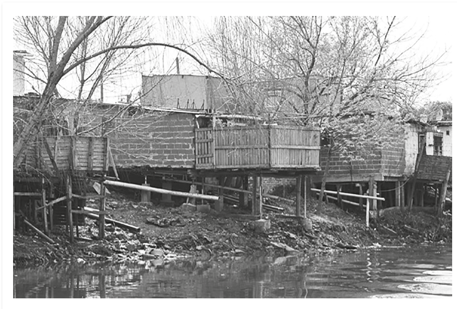
Viviendas de la villa 21-24 sobre el margen del Riachuelo Fuente: Defensoría del Pueblo de la Ciudad de Buenos Aires
