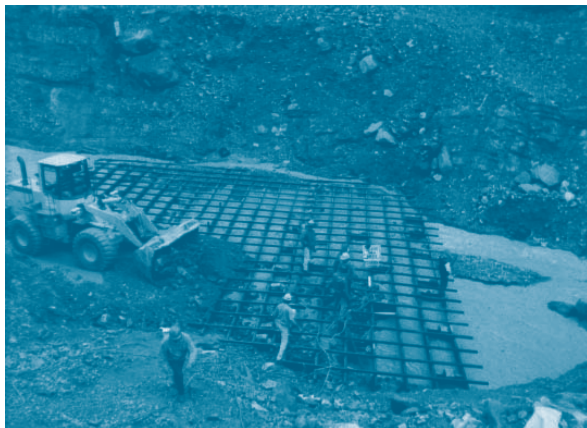
Figura 11. Protección de lecho con reja de acero estructural
