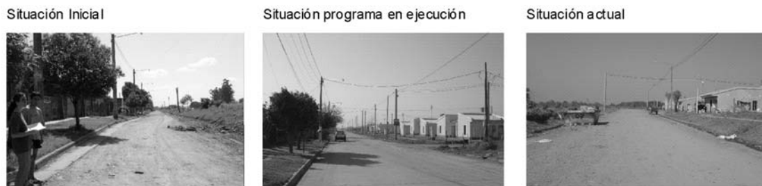
Figura 6. Intervenciones en la infraestructura. Fuente: NC y Proyecto IGEUS 2008-2009.
