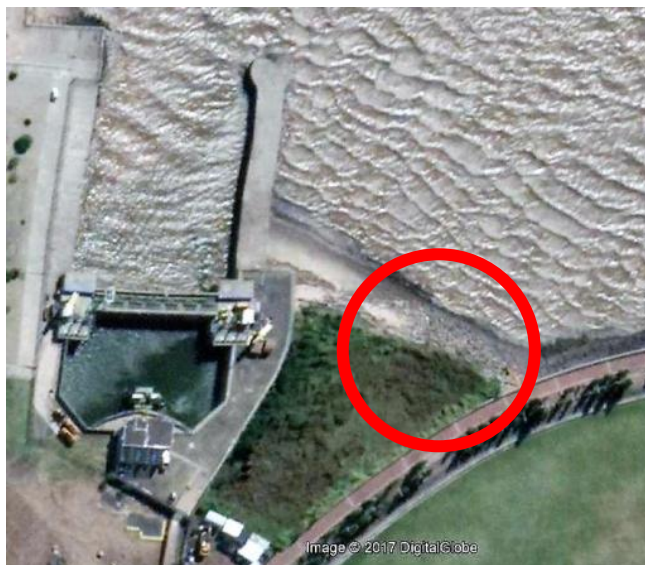
Fig. 2 Único sector de playa en la zona norte de la ciudad, se observa la acumulación de escombros llegados en las bajantes del río. Entre Ciudad Universitaria y el Parque de la Memoria.
