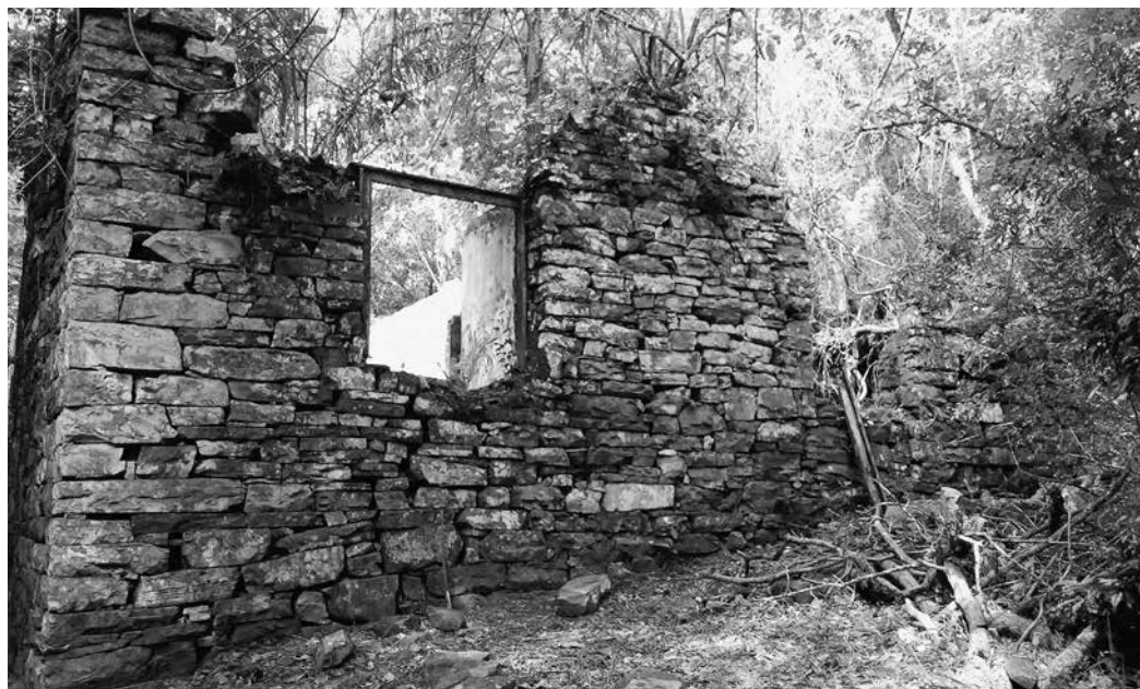
Figura 2. Muro lateral de la Estructura I; nótese el uso de la piedra casi sin tallar y ventanas modernas.
