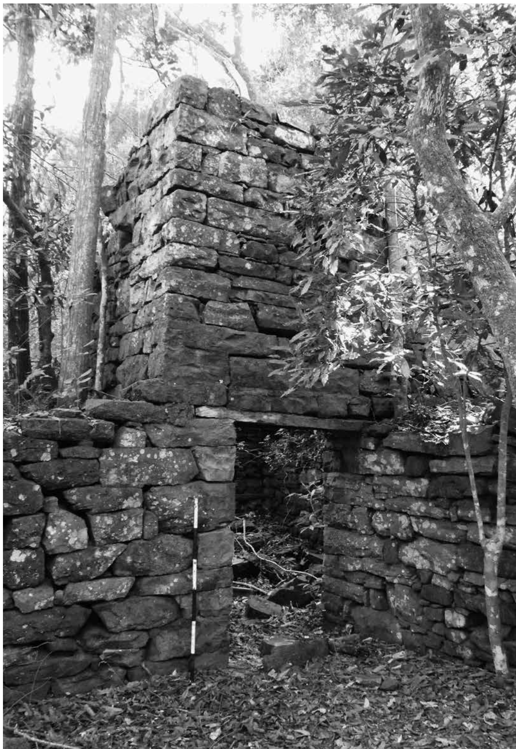
Figura 3. Estructura II de Teyú Cuaré, fragmento de la entrada en pie de los dos pisos, único sector no derruido.
