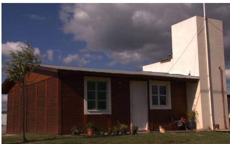
Foto 5: Exterior. Fuente: Proyecto PID 23121 – Vivienda de álamo.
