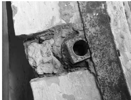
Figura 14. Muela N° 4. Orificio para alojar la cabria.
