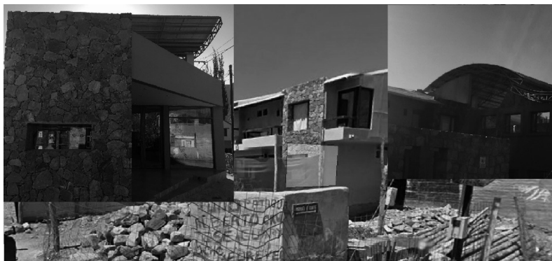
Figura 6 Hotel boutique en construcción. Localidad de Tilcara (2014-2016)
