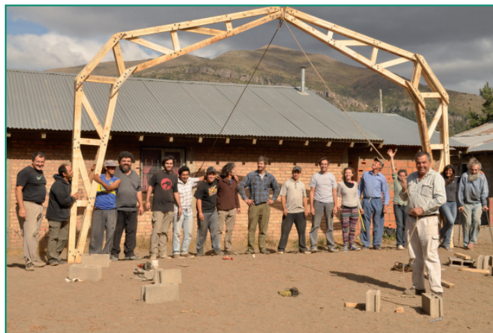
■ Foto 5: Primer pórtico construido de manera colectiva.
