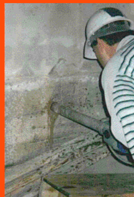
Figura III. Extracción de un testigo de una columna de hormigón armado.
