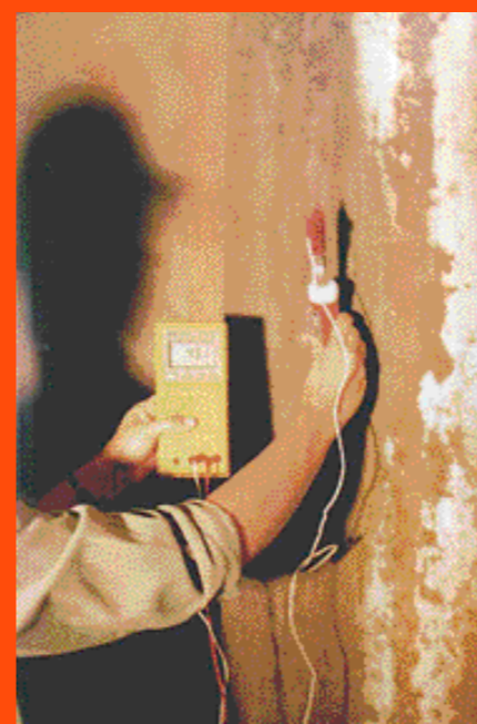
Figura II. Medición de la susceptibilidad del acero de las armaduras a la corrosión. En estado pasivo la armadura no es afectada; en estado activo la corrosión avanza aunque no existan manifestaciones visibles de corrosión. La medición se realiza con un voltímetro.
