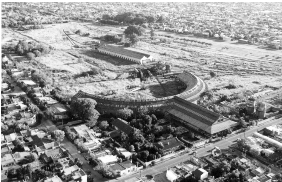
Vista de la Playa de Maniobras Santa Fe Cambios, ya sin su uso ferroviario. En primer plano, el taller de máquinas construido en 1907. Circa 1996 Fuente: Municipalidad de Santa Fe
