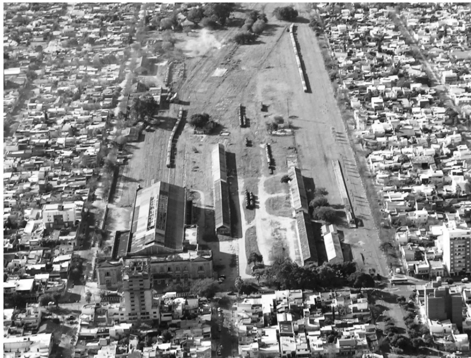
Vista del estado actual del sector Santa Fe Cambios. A la izquierda se observa el taller rehabilitado. Año 2011 Foto: autores del artículo
