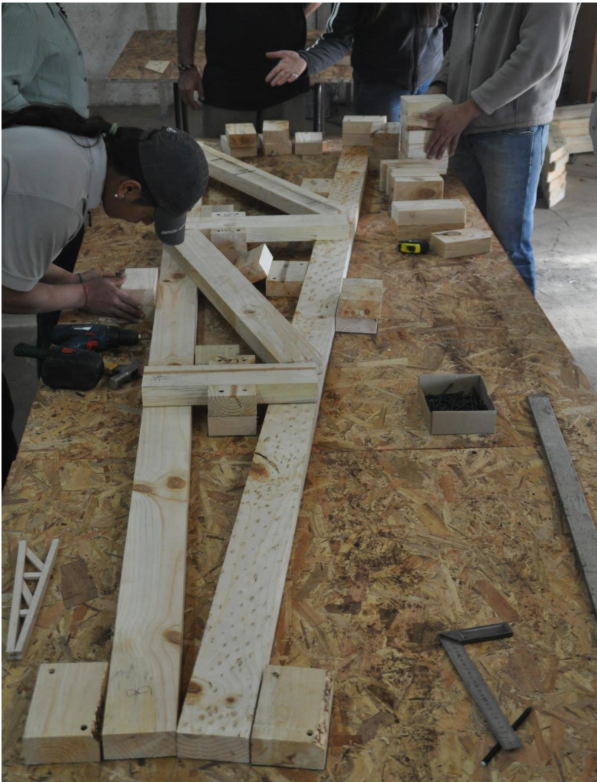
Imagen 4. Trabajo en taller. Fuente: Equipo Co-construcción de Conocimientos, 2013.
