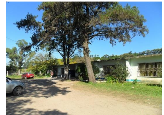
Figura 2. Escuela Primaria N° 190 "Dr. Macedonio Graz": acceso principal (izquierda), vista general (derecha).
