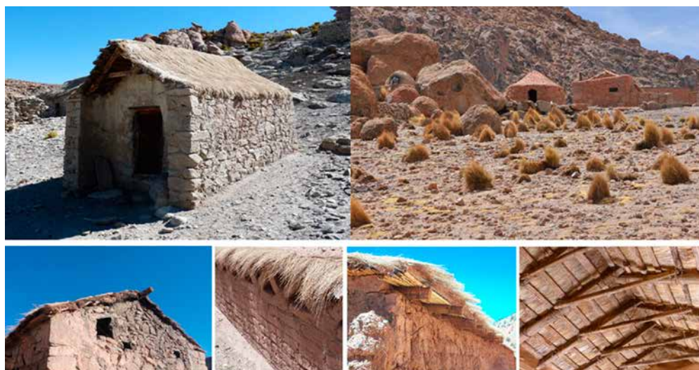
Figura 3: Técnicas constructivas en el campo: techados de guaya (sup.) y muros de piedra y adobe, e interior con estructura de madera de cardón (inf.). Fotografía: Julieta Barada
