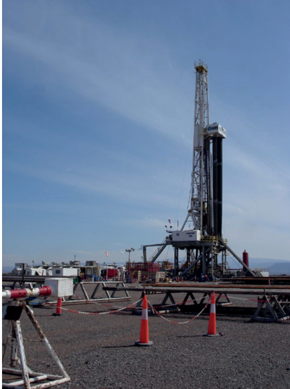
Imagen 1 – Torre de exploración en Aguada Federal (Provincia de Neuquén, 2016).
