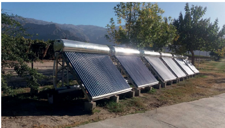
Imagen 5 – Colectores solares en unidad de producción de quesos de leche de cabra (Provincia de Salta, 2016).
