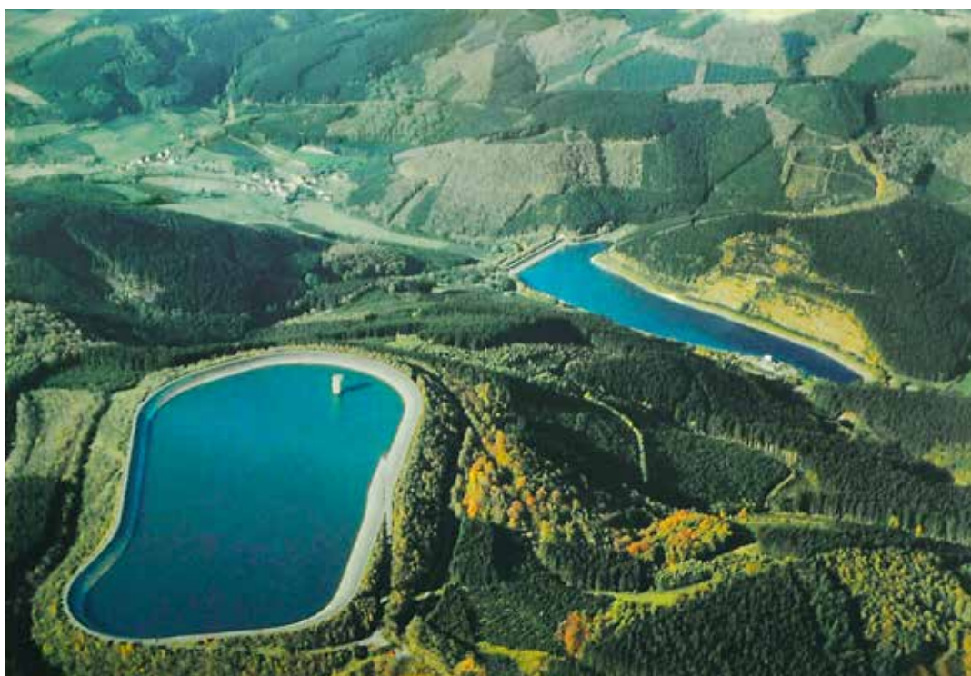
Figura 4. Vista aérea de reservorios de almacenamiento por bombeo en Rönkausen, Alemania, que datan de 1969. Tienen una diferencia de nivel de 270m; lleno, cada uno almacena alrededor de 1 millón de m 3 de agua y ocupa una superficie de 10ha. El superior (izquierda) puede acumular 140MW de energía potencial.
