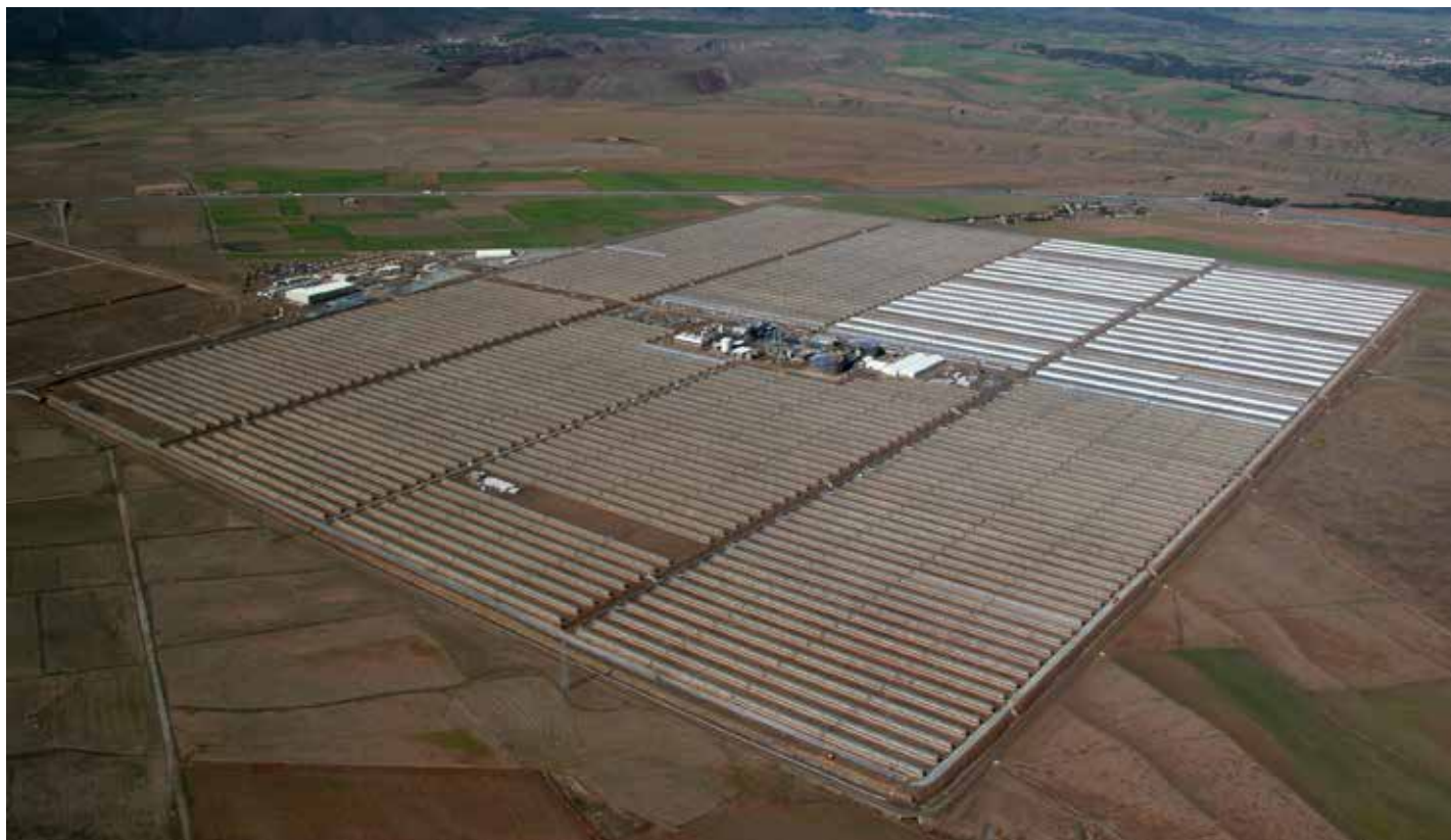
Figura 5. Vista aérea de la planta eléctrica termosolar Andasol, ubicada a 1100m sobre el nivel de mar en la provincia de Granada, Andalucía. Ocupa unas 50ha, genera anualmente unos 182.000MWh de electricidad, tiene una potencia de generación de 49,9MW y una eficiencia de conversión de la radiación solar a electricidad (pasando por vapor de agua que acciona turbinas) del 16%. Se compone de 624 colectores de radiación con aceite como fluido transmisor de calor hasta la planta de producción de vapor, y su sistema de almacenamiento de energía térmica en sales fundidas tiene capacidad de 1010MWh, que permiten operar las turbinas por 7,5 horas.
