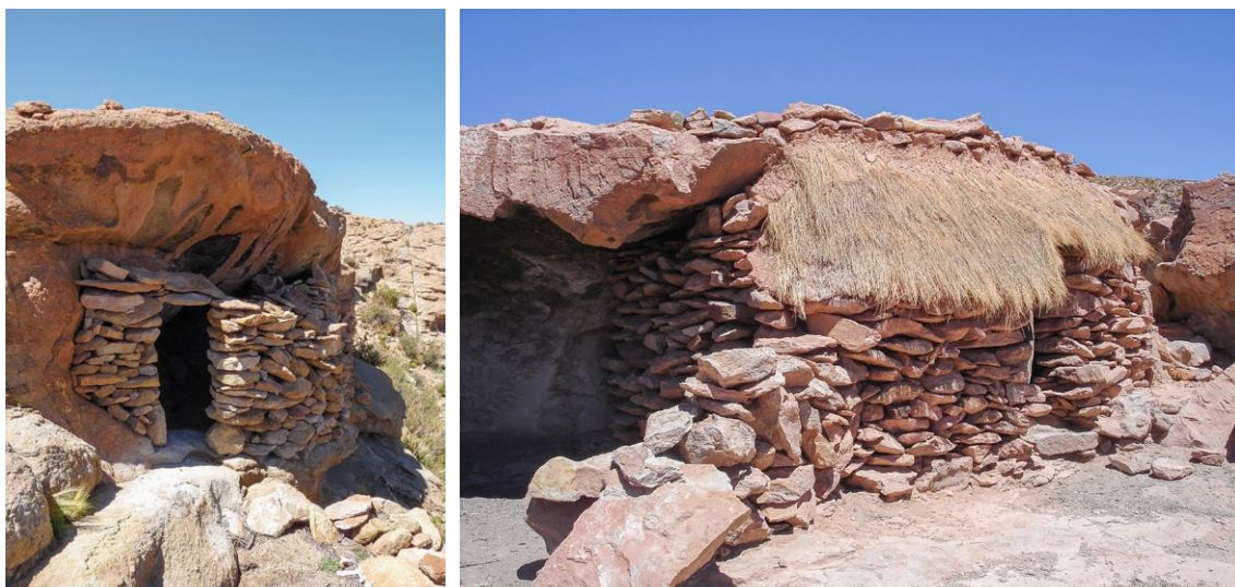
Figuras 6 y 7 El trabajo con "pirca seca" en dos estancias. Foto: Jorge Tomasi.
