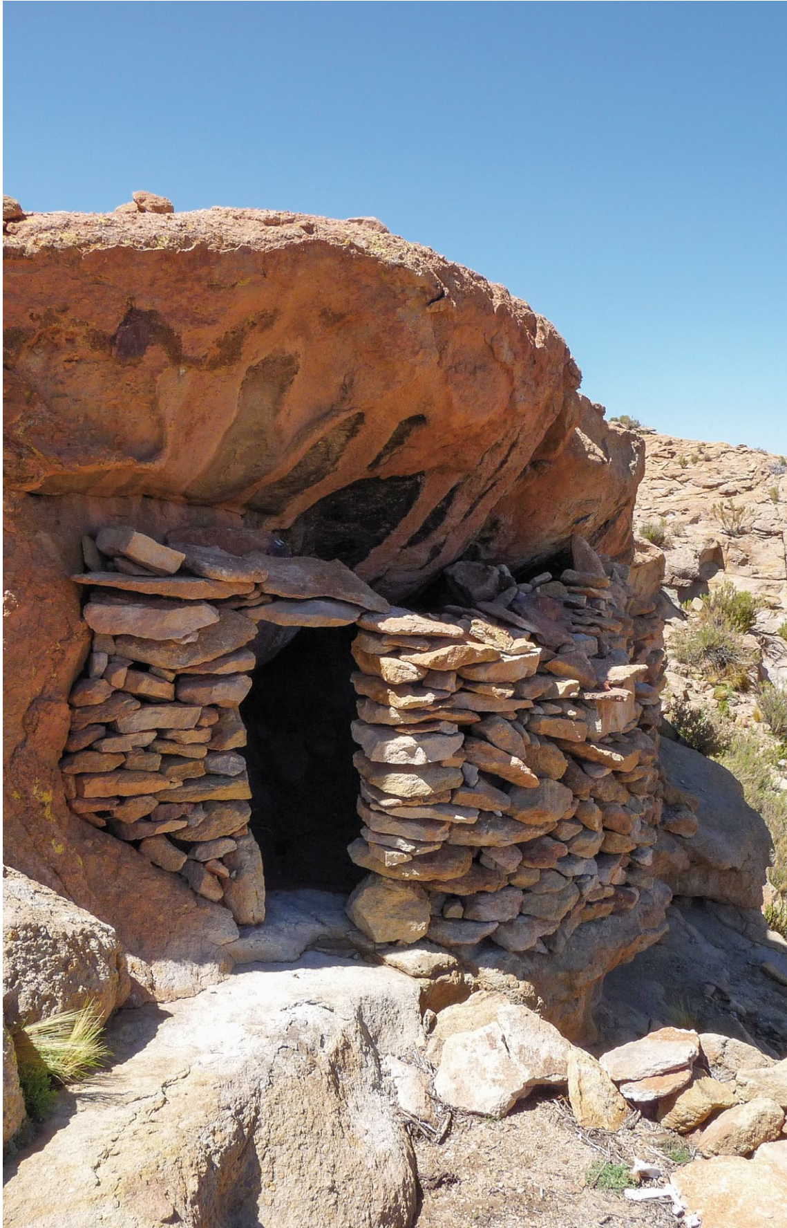
Figura 0 El trabajo con "pirca seca" en dos estancias. Foto: Jorge Tomasi.
