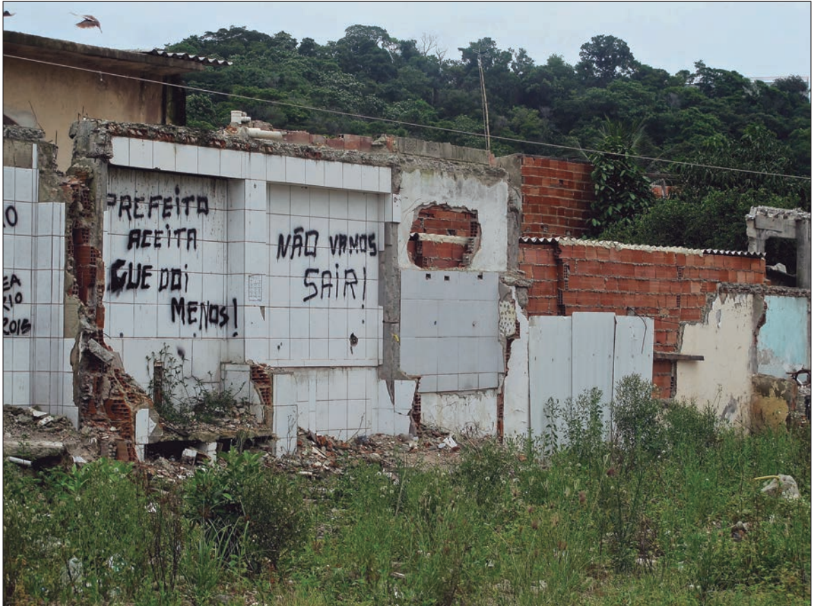
Resistencia. ¡No vamos a salir! ( Não vamos sair! ) expresa un grafiti entre los restos de las casas demolidas; 20 familias sostuvieron la lucha por la permanencia hasta el final del proceso.
