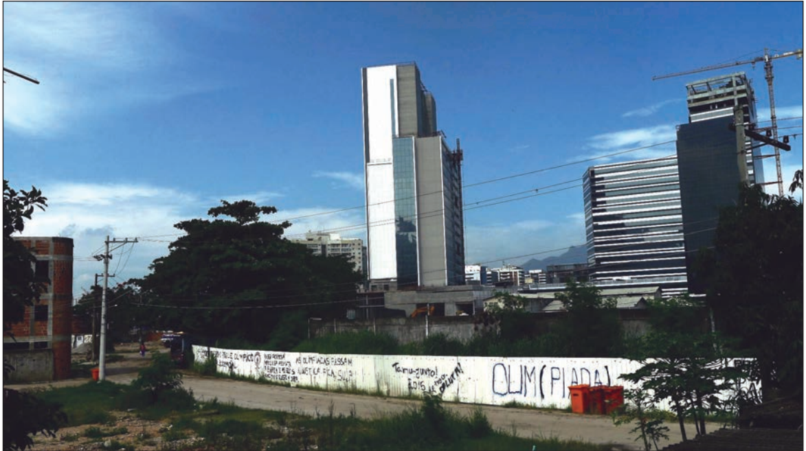
La cerca olímpica. En la construcción del Parque Olímpico, una cerca marca los límites entre dos formas antagónicas de pensar, construir y habitar la ciudad.
