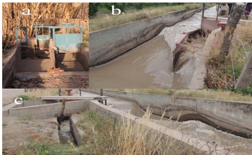
Figura 2: Compuertas sobre un canal secundario en el oasis del río Mendoza (a); compuertas en canal matriz en el oasis del río Tunuyán Superior (b y c). Fotografía: Jorge Ivars
