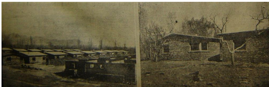
Figura 6: Viviendas del barrio 4 de Junio en construcción.
