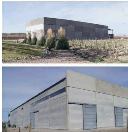
Figuras 4. Bodega H. Fotografías.
