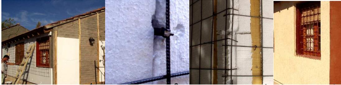
**Figura 7:** colocación de la aislación térmica: 1- unión al muro a) con alfajías de álamo y b) con malla SIMA; 2- detalle de colocación con malla cima 4.2 mm; 3- detalle de la esquina; 4- muro terminado c/revestimiento plástico.
