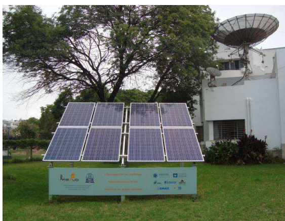
Figura 5: Sistema FV de 1,92 kW p instalado en la Asociación Argentina Amigos de la Astronomía.
