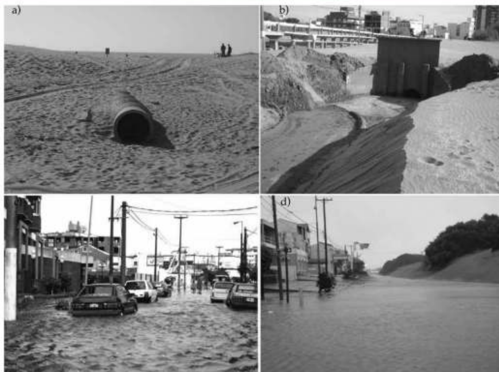
Figura 8. a) Caños pluviales colocados en la Av. Costanera, que descargan hacia la playa y el mar; b) desagüe que termina en la playa, donde posteriormente el flujo se conduce al mar; c) calles inundadas en la costanera de San Clemente del Tuyú.
