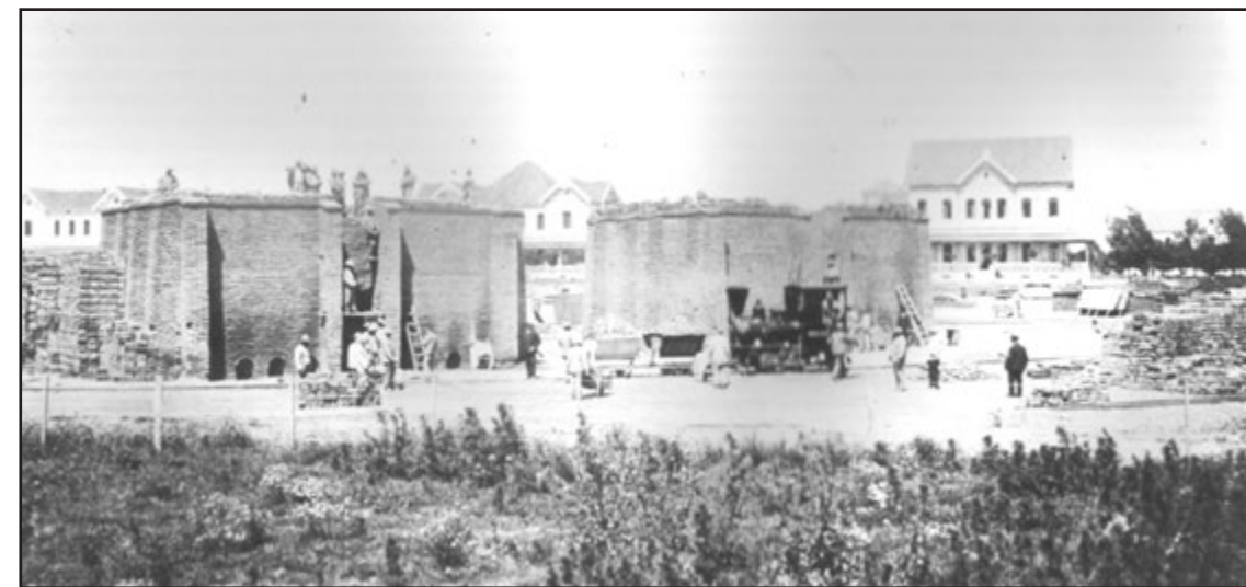
Colonia Nacional de Alienados. El proceso de construcción
