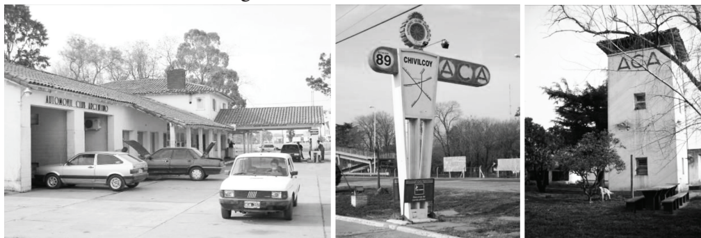
FIGURAS 11, 12 y 13 | YPF ACA: Chivilcoy y detalles de cartel identificador y torre de agua
