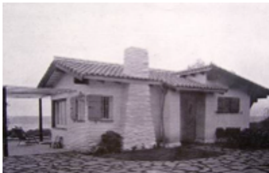
Figura 14. Foto de la casa de fin de semana en San Isidro. Arq. A. Rodríguez Etcheto. Procedencia: Viviendas Argentinas, Tomo I, 1940.
