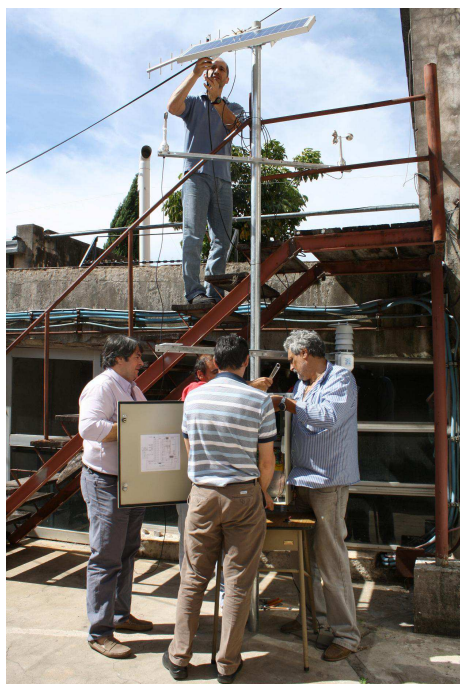
Figura 1: Recepción de Equipos
