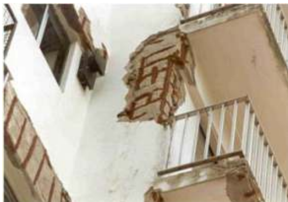
Fotografía 5. Columnas, vigas, lozas y fachada de un edificio con signos visibles de deterioro causados por la corrosión de las armaduras.
