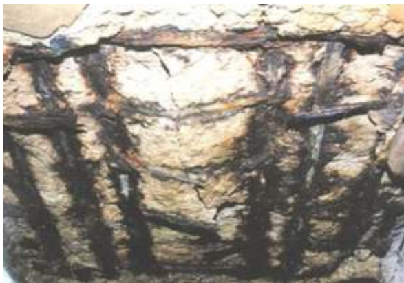
Fotografía 5. Columnas, vigas, lozas y fachada de un edificio con signos visibles de deterioro causados por la corrosión de las armaduras.
