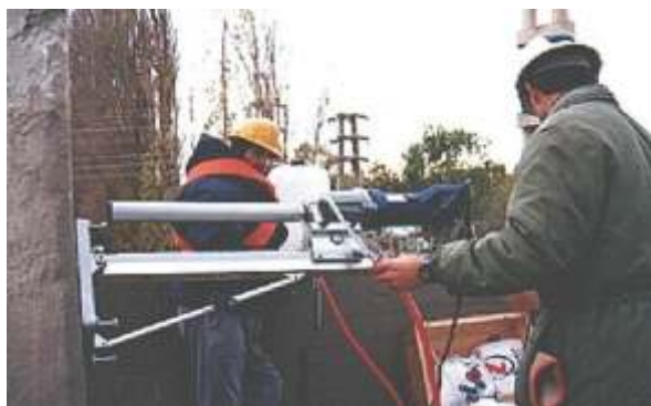
Fotografía 1. Procedimiento para la extracción de testigos de hormigón
