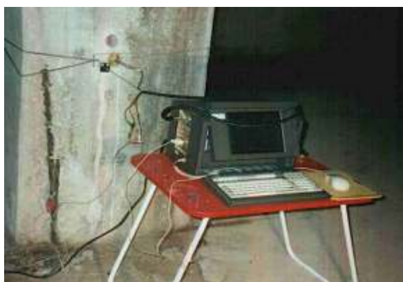
Fotografía 3. Procedimiento para la evaluación de velocidades de corrosión en barras de refuerzo refuerzo
