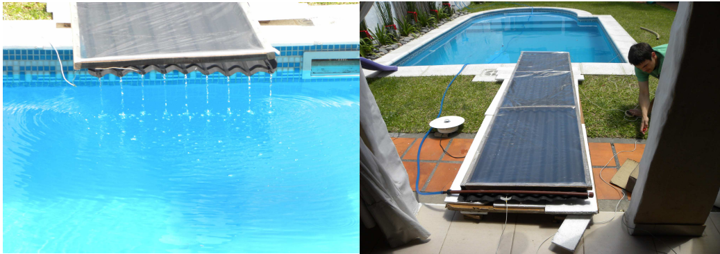
Figura 6: Sist. en funcionamiento con el vertido por canales y Vista general con la cubierta instalada
