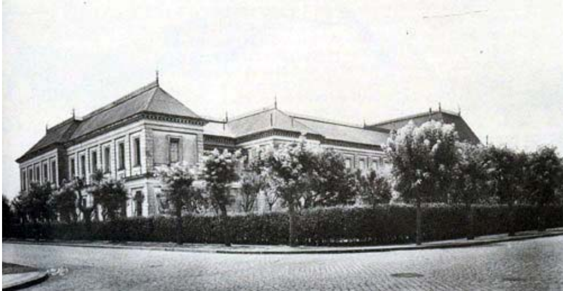
Vista del edificio del Asilo con sus dos pisos de altura y el jardín que lo rodeaba.
