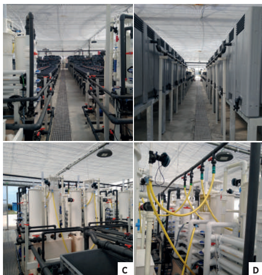
FIGURA 4. Módulos IMTA del proyecto AquaMMin. Vista frontal desde la entrada del invernadero donde se observa la disposición de los tanques de cultivo (a), vista de los tanques de cultivo de peces (zona más alta) (b), vista de los tanques de cultivo de vegetales y/o algas (zona más baja) (c), vista del sistema de filtración (d).
